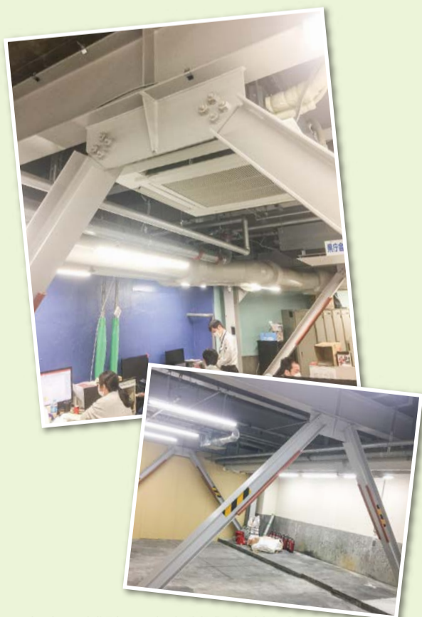
県庁内の補強工事を終えた箇所
