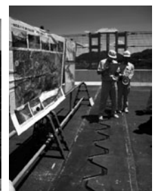
新設道路工事現場
